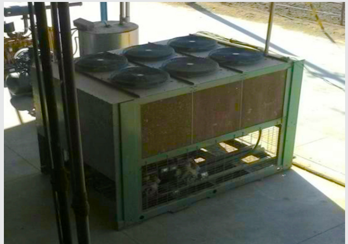
Fig. 12. Compresor del Chiller 30 HP
