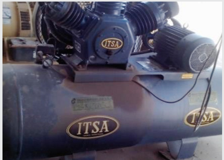
Fig.13. Compresor de 10 HP
