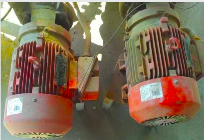
Fig. 11. Bombas de agua para el chiller
