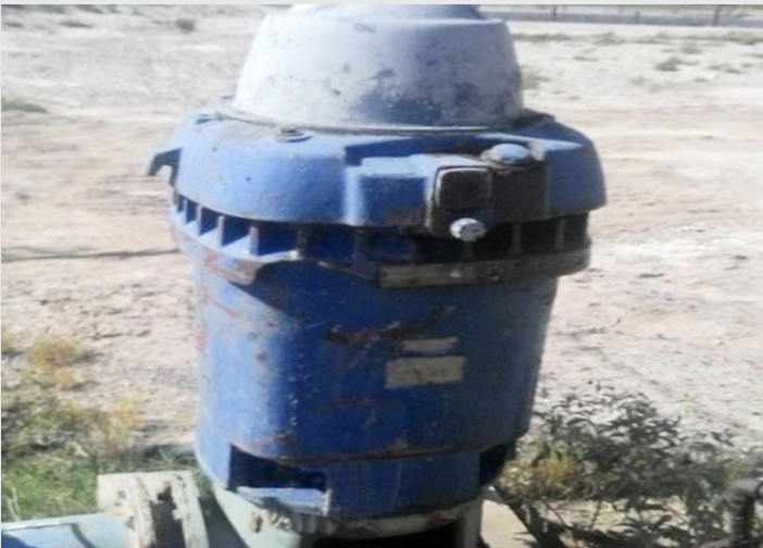
Fig. 9. Bomba No.1 de pozo profundo de 100 HP
