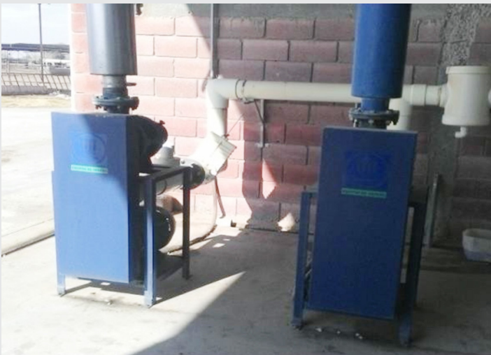
Fig. 10. Bombas de vacío 30 HP cada una
